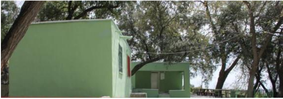
Dört Yol'daki Karabiyık Dede Türbesi 43
